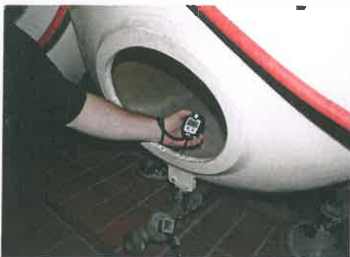
Messung mit mobilem Prüfgerät
